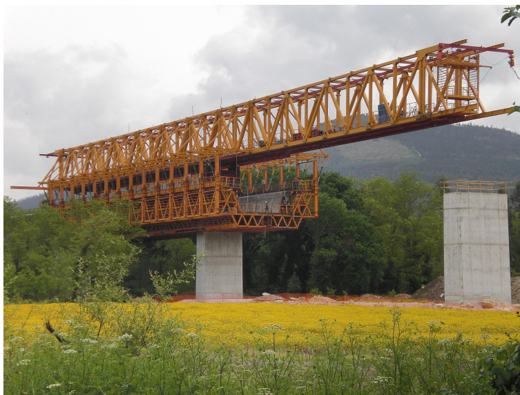
Ejecución del tablero con autocimbra
