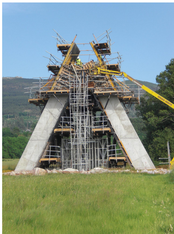
Ejecución de los puntos fijos en A
